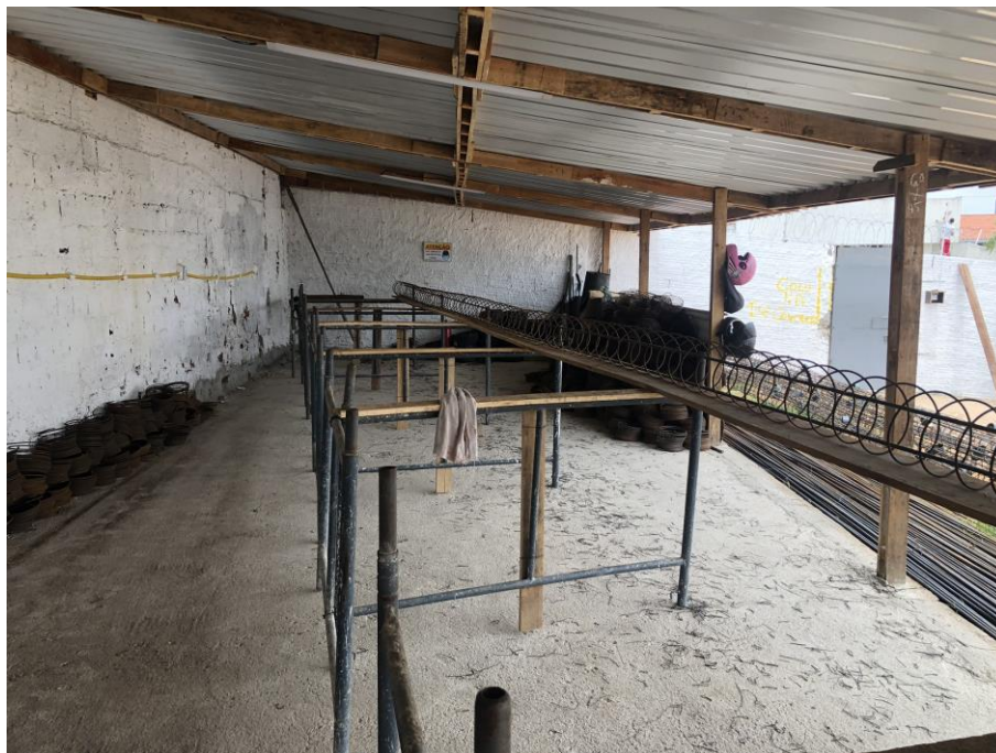
Figura 7: serviços preliminares e instalação provisória – canteiro de obra
