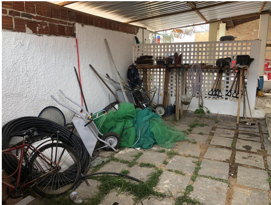
Figura 9: serviços preliminares e instalação provisória – canteiro de obra
