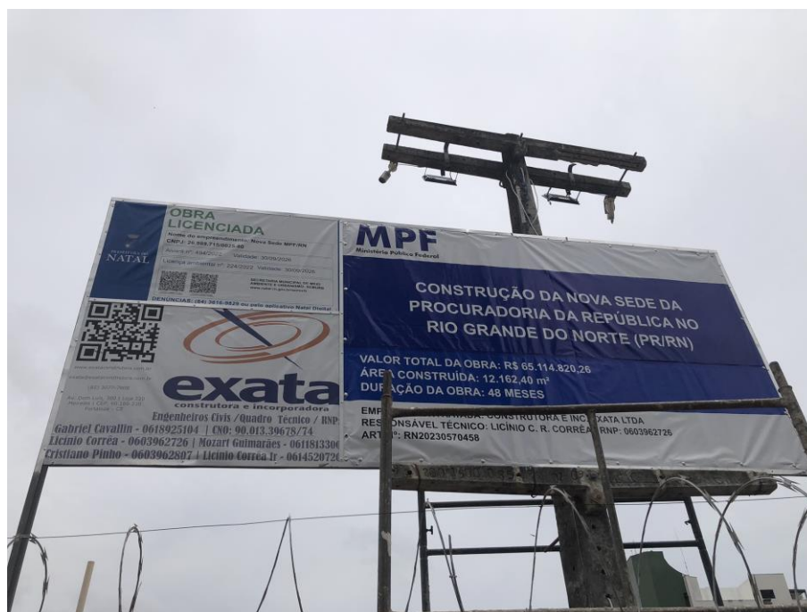
Figura 1: serviços preliminares e instalação provisória - placa de obra
