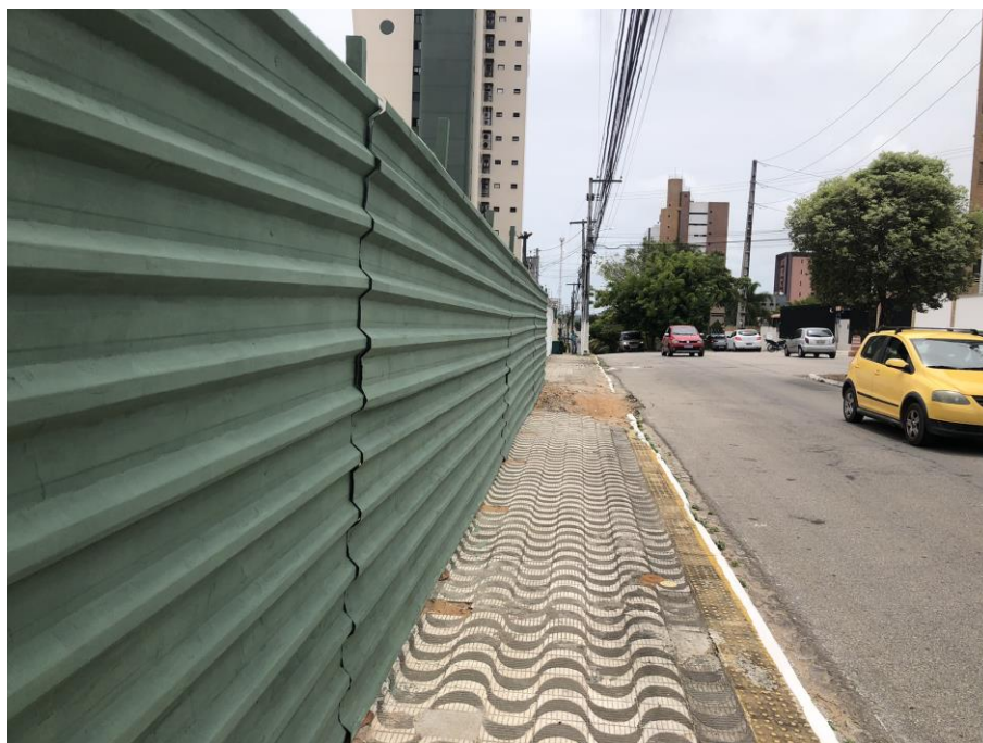
Figura 13: serviços preliminares e instalação provisória – proteção - tapume
