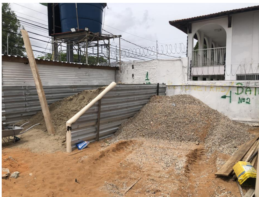
Figura 6: serviços preliminares e instalação provisória – canteiro de obra
