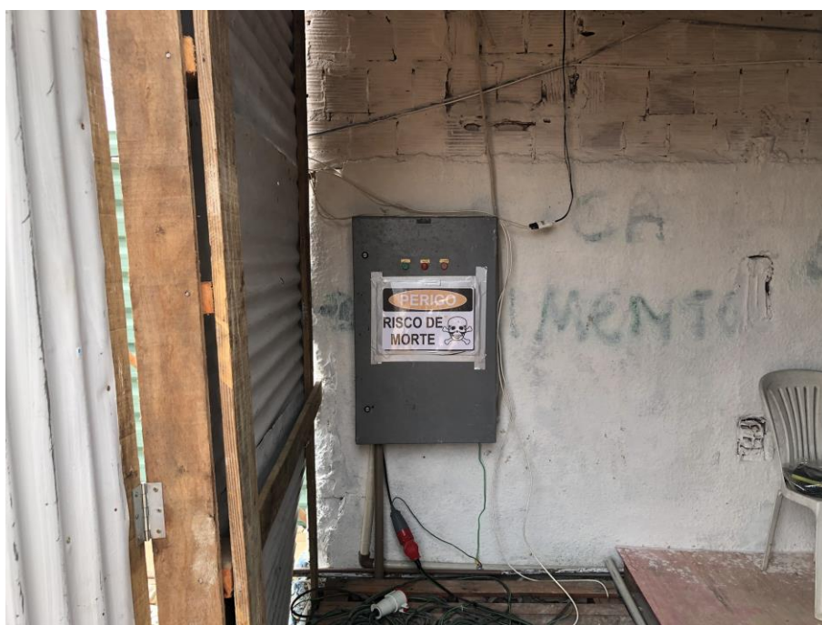
Figura 8: serviços preliminares e instalação provisória – canteiro de obra
