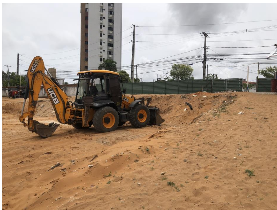
Figura 14: movimentação de terra
