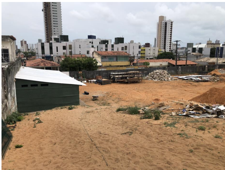
Figura 11: serviços preliminares e instalação provisória – canteiro de obra
