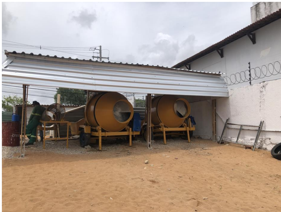
Figura 5: serviços preliminares e instalação provisória – canteiro de obra
